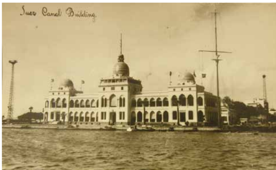
F.2. Vista del "Suez Canal Building".
